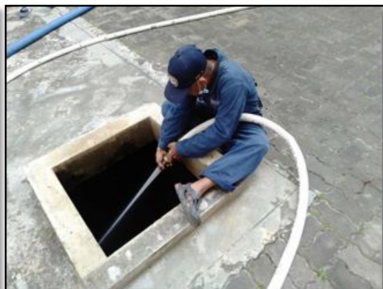
รูปที่ ๑๘ และ ๑๙ แสดงการล้างทำความสะอาดถัง
