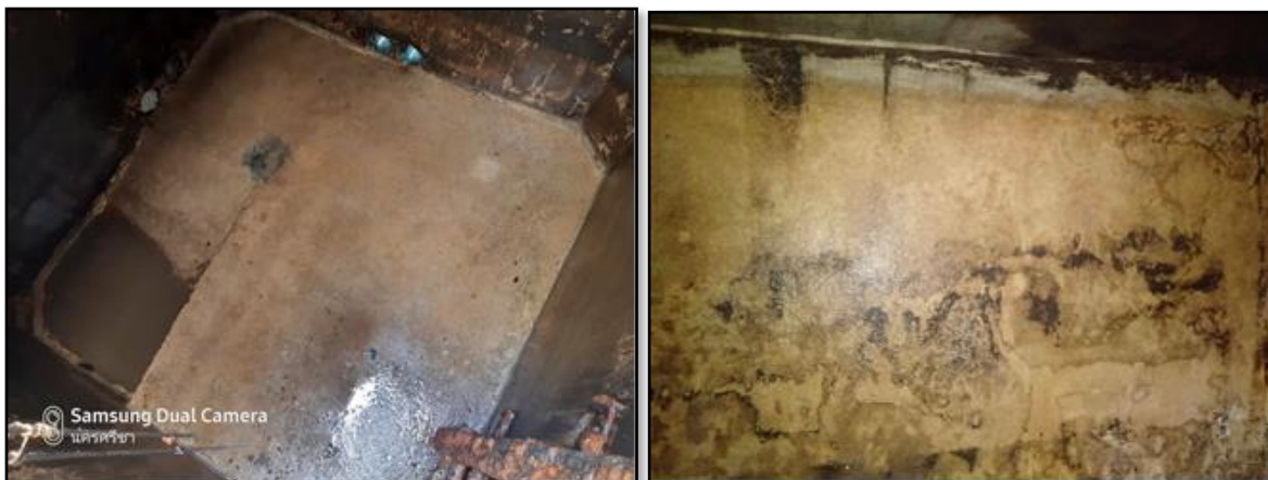
รูปที่ ๒๐ และ ๒๑ แสดงสภาพถังหลังจากทำความสะอาดแล้ว
