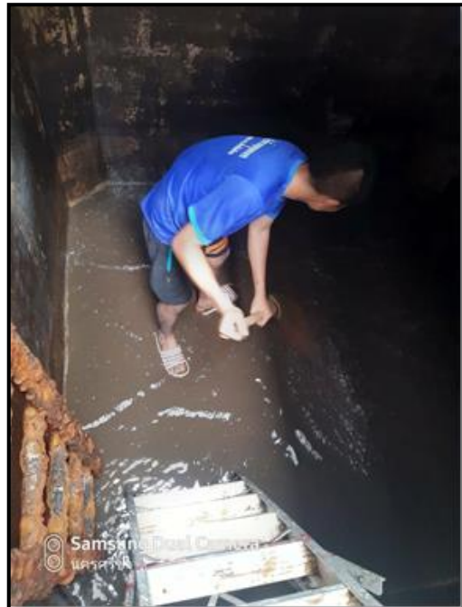
รูปที่ ๑๖ และ ๑๗ แสดงการล้างทำความสะอาดถัง
