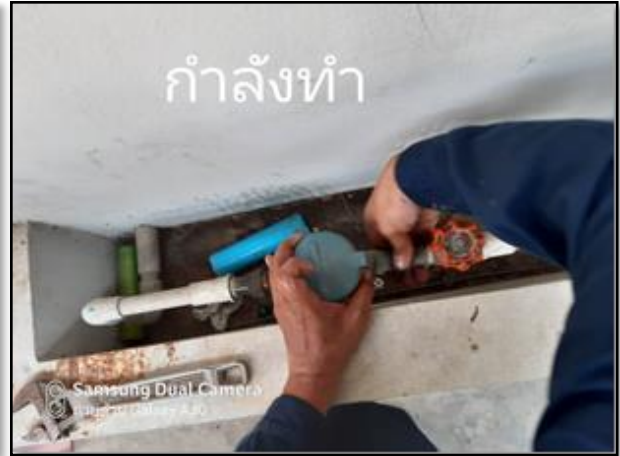
รูปที่ ๗ แสดงการถอดสลักยึด
