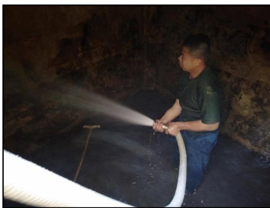
รูปที่ ๑๘ และ ๑๙ แสดงการล้างทำความสะอาดถัง
