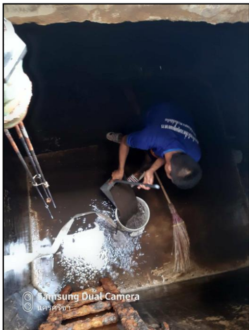
รูปที่ ๑๖ และ ๑๗ แสดงการล้างทำความสะอาดถัง
