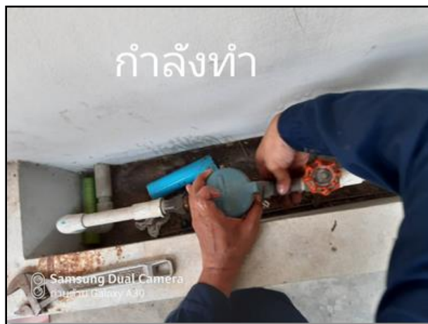
รูปที่ ๑๒ แสดงการประกอบมาตรวัดน้ำเข้าที่เดิม
